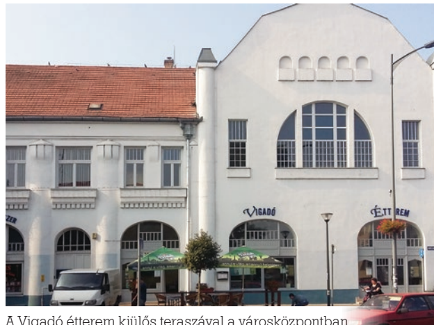
A Vigadó étterem kiülős teraszával a városközpontban
