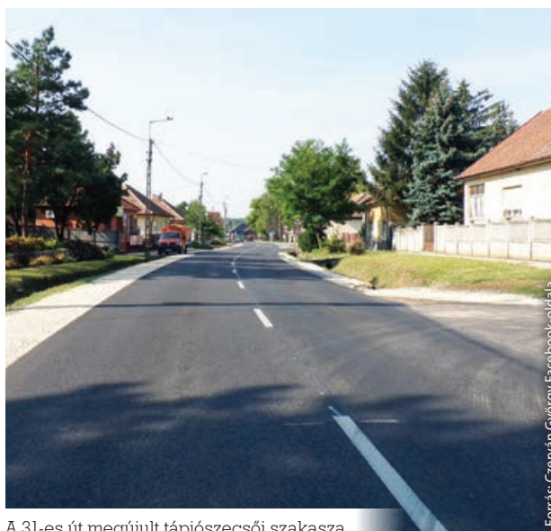
A 31-es út megújult tápiószecsői szakasza
