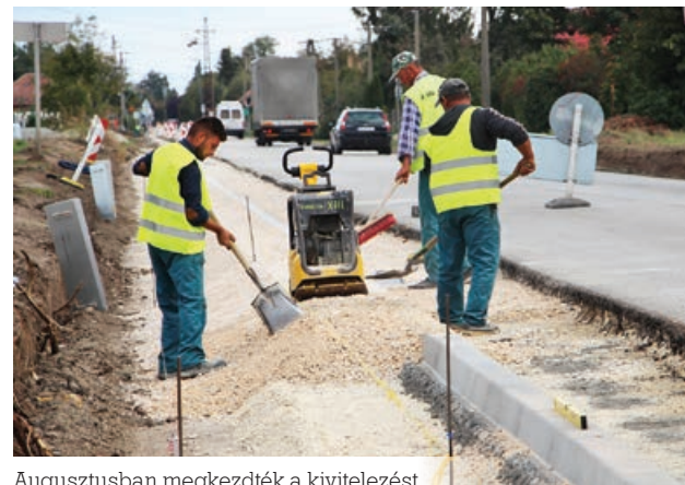
Augusztusban megkezdtek a kivitelezést
