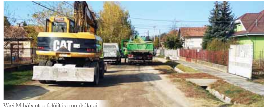
Váci Mihály utca felújítási munkálatai
