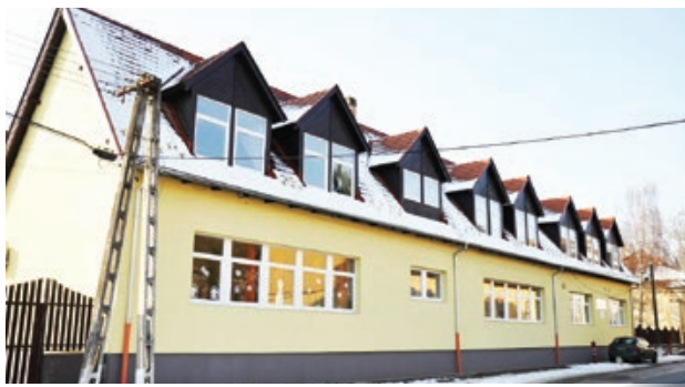
A felújítás után gazdaságosabb az általános iskola fenntartása
