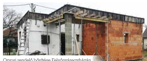
Orvosi rendelő bővítése Felsőnyáregyházán
