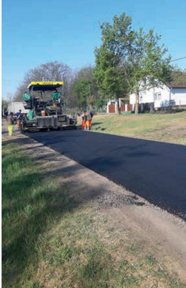
Gőzerővel dolgoznak az útfelújításokon
