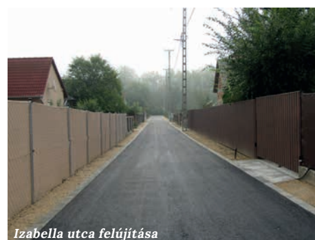
Izabella utca felújítása
