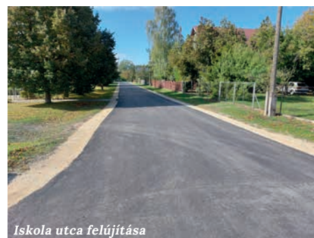
Iskola utca felújítása
